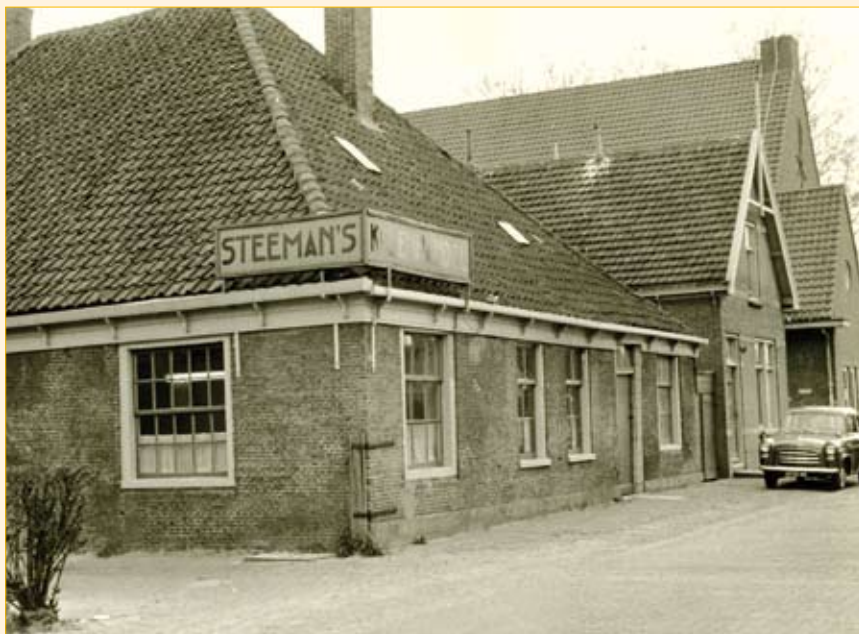
Het pand van Steeman's Kolenhandel aan de Overtoom.
