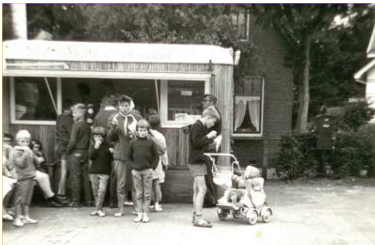
De eerste patatwagen (de Klomp) gerund door Niek Steeman (22), tegenover hotel Borst.
